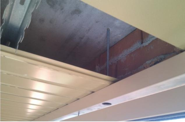
Il fatto di scaricare tutto il peso del sistema sul profilo inferiore, lo rende unico e permette di installarlo nei controsoffitti senza nessun problema.
