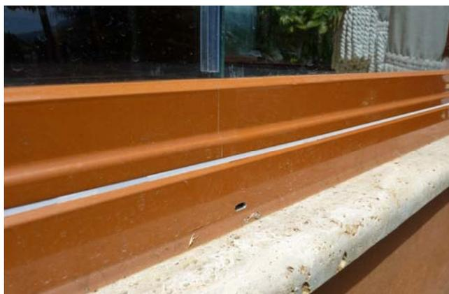
Sistema di drenaggio dell'acqua che si può accumulare nel sistema.
