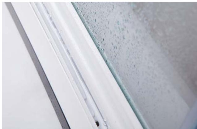
La nostra guida inferiore è dotata di un canale di raccolta e scarico dell'acqua della condensa accumulata.
