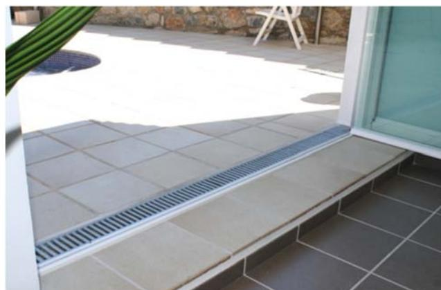
Il sistema si può incassare completamente e creare uno scarico per l'acqua prodotta dalla condensa nella parte interna del vetro.
